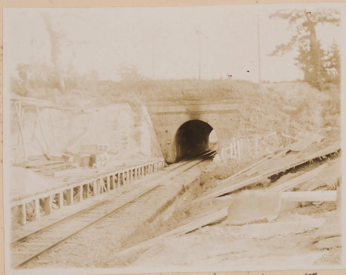
宝達川ノ天井川 (川底ヲトンネルニテ横キル)
